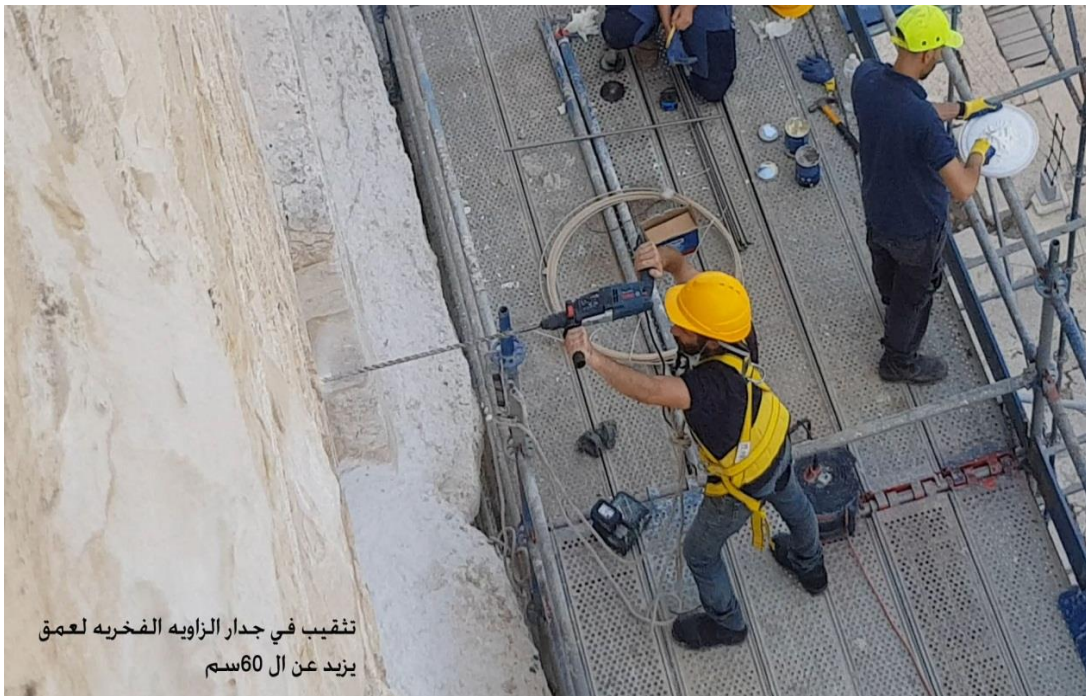
(11) تثقيب في جدار الزاوية الفخرية لعمق يزيد عن ال (60) سم
