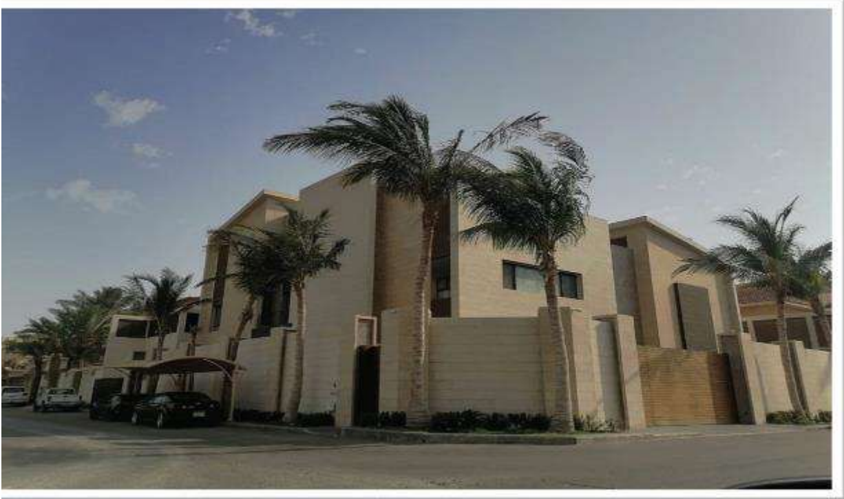
الصورة (25): المظهر البصري اللائق لواجهات المباني في حي المحمدية.
