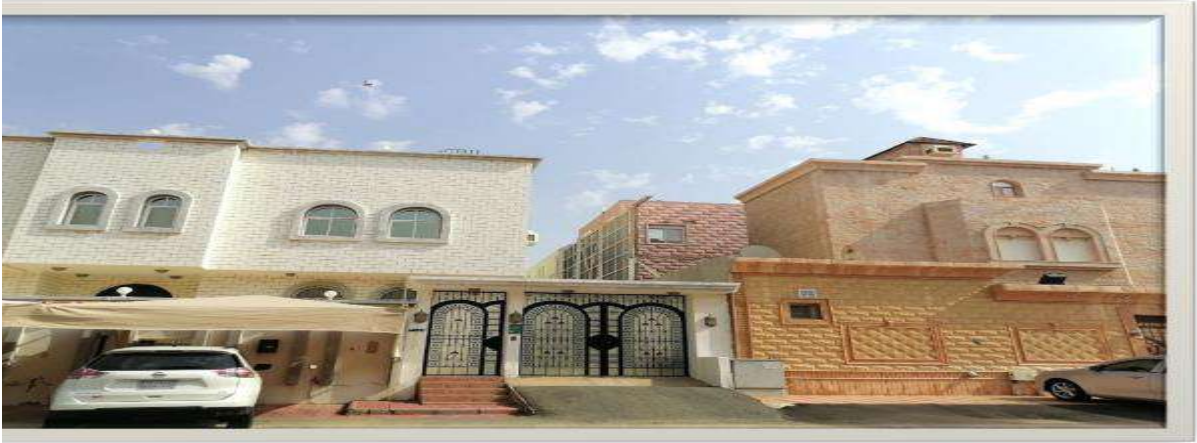
الصورة رقم (21): المظهر البصري للواجهات سيراميك وحجرية في حي المحمدية. وكذلك الواجهات باستخدام الخشب وتمتاز بالشكل الأنيق والفخامة بالمظهر والقدرة الهائلة على العزل الحراري وخاصة في المناطق الحارة.
