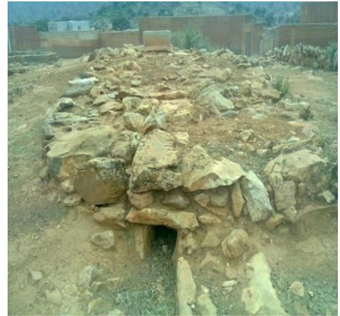
وإضافة إلى النوع السابق هناك منشآت المائية أخرى تسمى محليا بـ"إفرضن" وهو عبارة عن أحواض مائية كبيرة تستعمل لتخزين مياه الأمطار، ويغطي مساحة تزيد عن 150 متراً مربعاً ويزيد ارتفاعه عن 15 أمتار. وتنتشر بشكل في المجالات الجبلية حيث ندرة المياه واعتمادها الكلي على مياه الأمطار، وهي أيضاً من خصوصيات المناطق الريفية في المناطق الجنوبية الغربية الأطلس الصغير الغربي، وخاصة بمناطق السوس الأقصى كـ"لخصاص، وأيت باعمران، أنزي"
