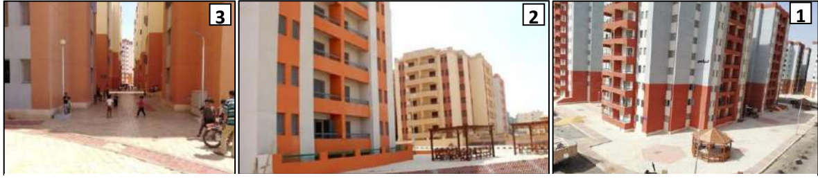
شكل رقم 9: يوضح علي التوالي: وجود كسرات بالتصميم المعماري لتكوين الظلال (جريدة الوفد الالكترونية) - الفتحات صغيرة وضيقة للتقليل من الاكتساب الحراري (جريدة الوفد الالكترونية) - مداخل العمارات في منطقة مظلمة (جريدة صوت الامة الالكترونية).
