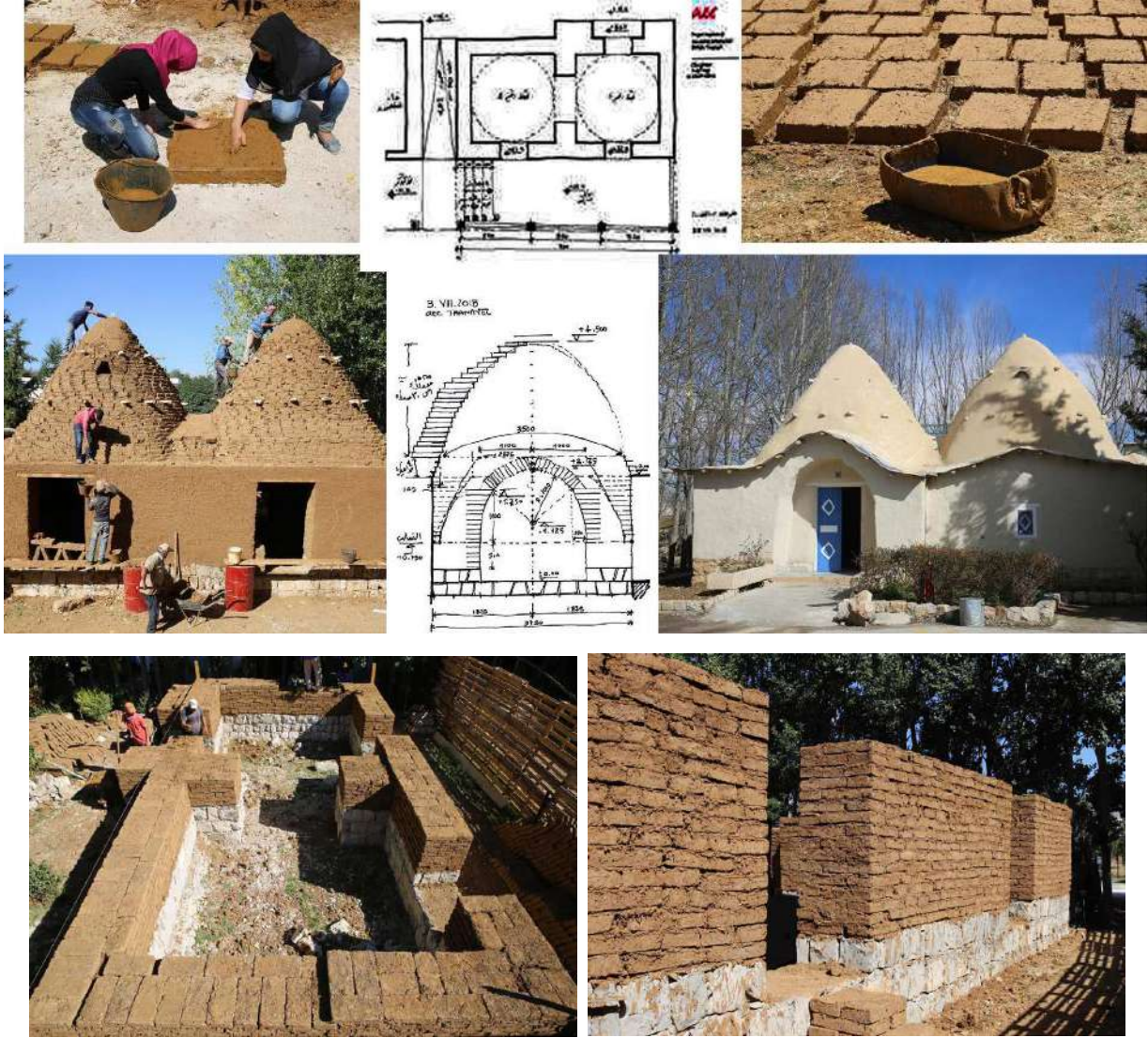
الشكل (20): مسكن طيني مقبب معاصر في لبنان لعائلة سورية بني كنموذج من قبل المهندسة هدى قساطلي لتعزز ثقافة بناء هذه المساكن - المصدر: (Kassatly, 2019)
