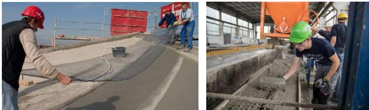
الشكل (4) تقوية قشرية سقف مدرج باستخدام عملية التصفيح (يسار، الصورة: Ulrich van Stipriaan، انظر على سبيل المثال <sup>[52], [50], [45], [10]</sup>) وتنفيذ جائر خرساني كربوني بطول 5 أمتار باستخدام طريقة الصب (يمين، <sup>[31]</sup>)
