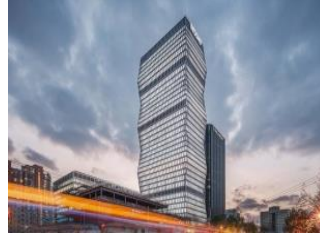
الشكل (2) Soho Gubei Tower
