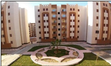
شكل (26) المنظر الخارجي للمبنى
