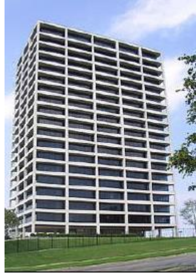
شكل 17 برج التامين لرجال الأعمال - أمريكا مصدر الصورة en.wikipedia.org
