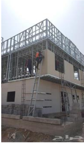
شكل 20 منزل انشاء معدني في السعودية في مراحل البناء مصدر الصورة www.haraj.com.sa
