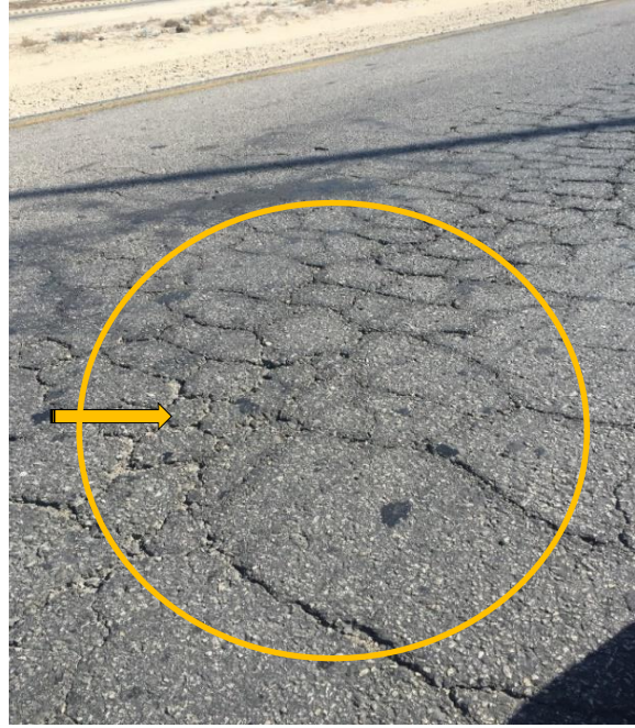
الشكل (5-أ) شقوق تمساحية عالية الشدة - المقطع (A1)
