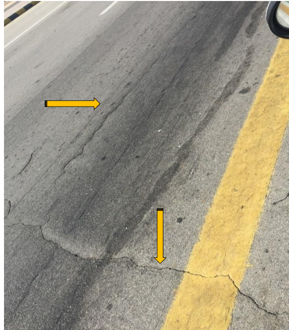
الشكل (5-ج) الشقوق الطولية والعرضية منخفضة الشدة - المقطع (B5)
