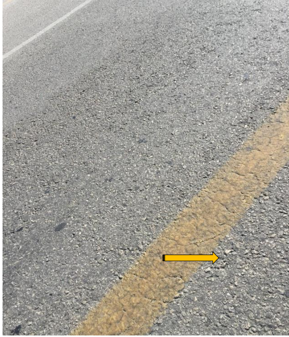
الشكل (5-ب) بري أو صفل الحصى متوسط الشدة - المقطع (A4)
