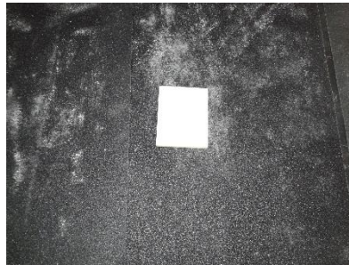
الشكل (2) استخدام ورق الشحذ لتنعيم السطح
