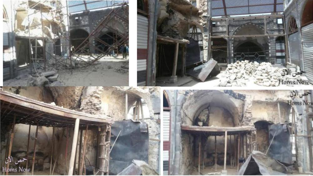
الشكل (19) الانهيار الحاصل في بعض أجزاء السوق بعد الترميم
